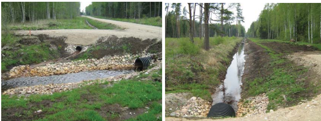
Valsts nozīmes ūdensnotekas Macupe renovācija (2009.gadā).
