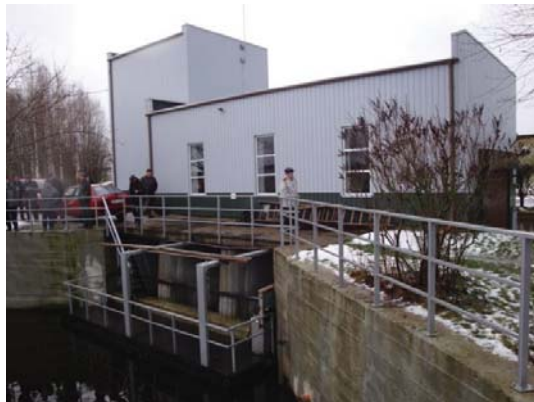
Sūkņu stacija Ogre 2 (renovēta 2007.gadā)
