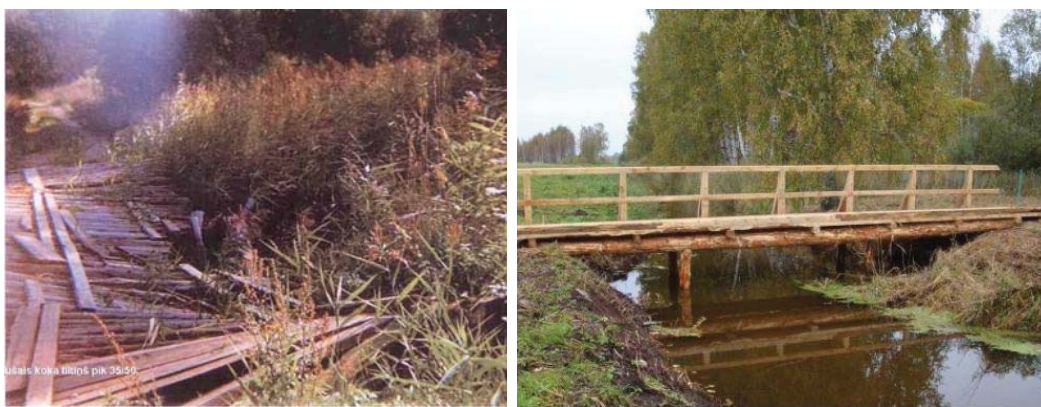
Valsts nozīmes ūdensnoteka Križutu strauts pirms un pēc rekonstrukcijas (2009.gadā).
