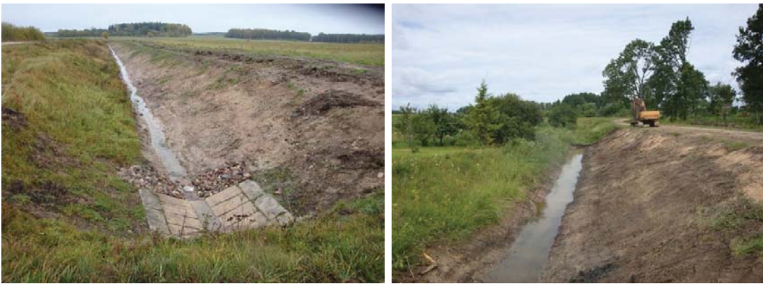
Valsts nozīmes ūdensnotekas Jugliņa rekonstrukcija (2009.gadā).
