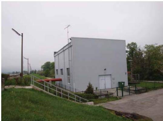
Sūkņu stacija Ikšķile 1 (renovēta 2006.gadā)
